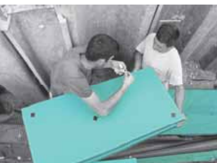
Закрепване на FIBRANxps 300-L плочи върху хидроизолационна мембрана при фундаментни стени с FIBRANstick лепящи ленти.
