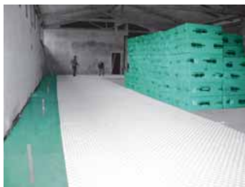
FIBRANxps 300-I топлоизолация под подово отопление
