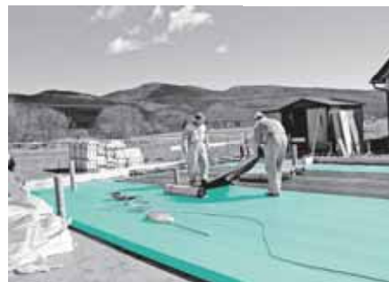
FIBRANxps 400-L топлоизолация под фундаментна плоча
