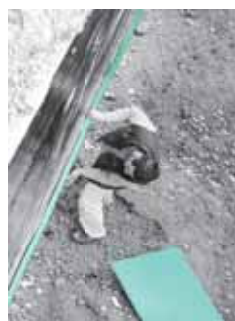
Закрепване на FIBRANxps 300-L плочи върху хидроизолационна мембрана при фундаментни стени с FIBRANstick лепящи ленти.
