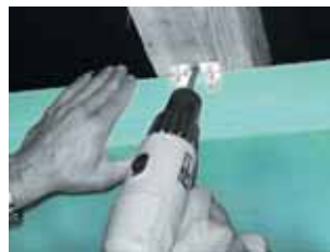
Полагане на FIBRANxps MAESTRO-L видима топлоизолация, предпазваща помещенията от свръхпрегревяване през лятото и прекомерно изстудяване през зимата
