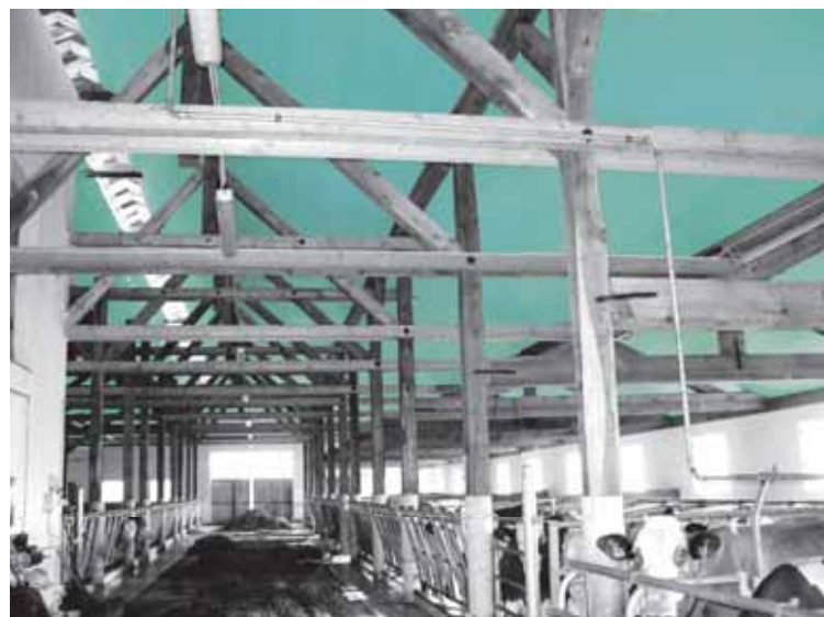
Полагане на FIBRANxps MAESTRO-L видима топлоизолация, предпазваща помещенията от свръхпрегревяване през лятото и прекомерно изстудяване през зимата
