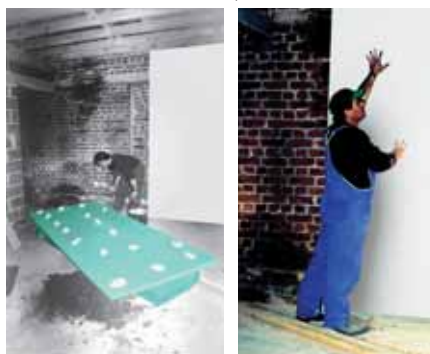
FIBRANxps FABRIC вътрешна топлоизолация в комбинация с гипскартон
