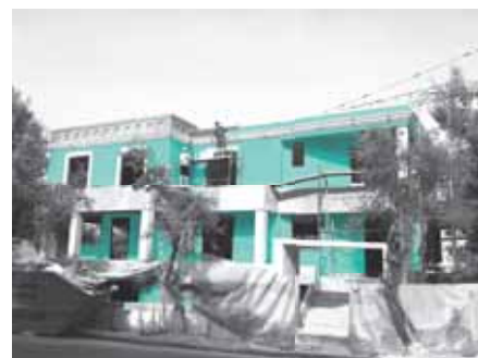
Изпълнена фасада с FIBRANxps FABRIC
