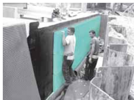
Топлоизолация върху покрив с FIBRANxps 300-L
