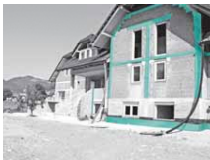
Топлоизолация на топлинни мостове (противоземетръсни греди) чрез използване на FIBRANxps ETICS
