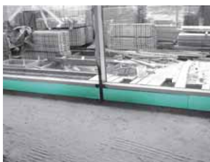
Отстраняване на топлинни мостове около прозорците
