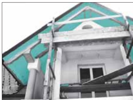
Малък покрив, направен с FIBRANxps ETICS
