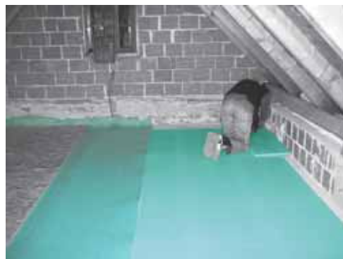
Полагане на FIBRANxps 300-I в конструкция на под със сух монтаж като топлоизолация и звукоизолация
