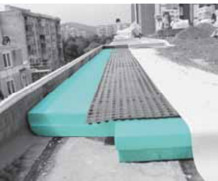
Детайл на обърнат зелен покрив с FIBRANxps 300-L (екстензивно озеленяване)
