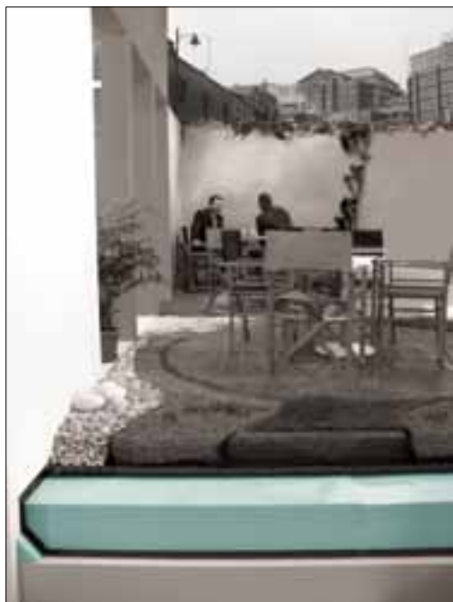
Елементи на екстензивно озеленен покрив. Вложените топлоизолационни плочи FIBRANxps са с дебелина 20 cm
