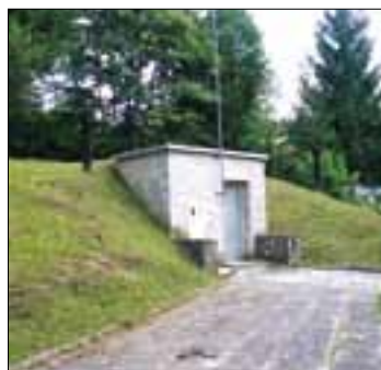
Поддържане на постоянна температура и предотвратяване повреждането на хидроизолационната мембрана над подземно съоръжение - воден резервоар
