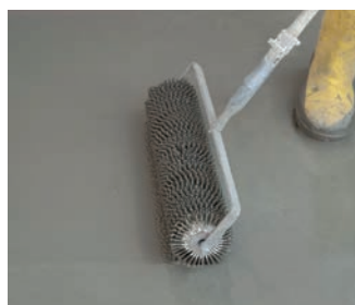
Обезвъздушаване с иглен валик
