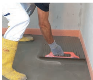
Разстилане на шпакловъчната смес
